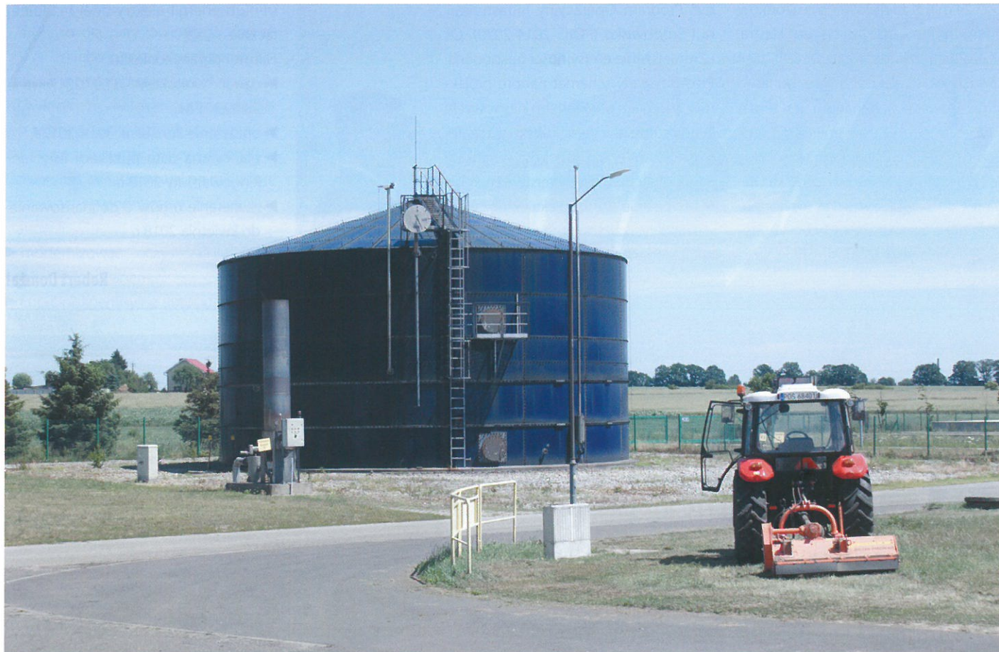
► Magazyn biogazu na terenie oczyszczalni ścieków
