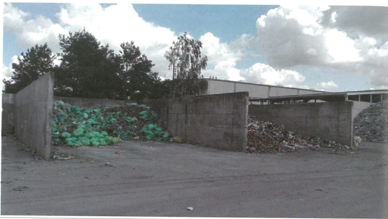
Fot. 1. Boksy magazynowe na stłuczkę szklaną i drobny złom stalowy
