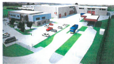
Nowoczesna hala przyjęcia i sortownia odpadów w Tychach.
