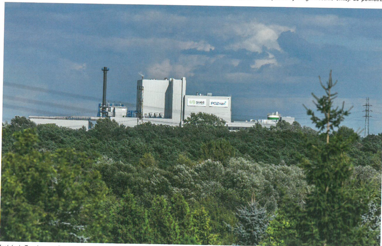
Instalacja Termicznego Przekształcania Odpadów Komunalnych (ITPOK) w Poznaniu
