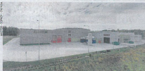
Międzygminny Zakład Kompleksowego Zagospodarowania Odpadów Komunalnych w Tychach
