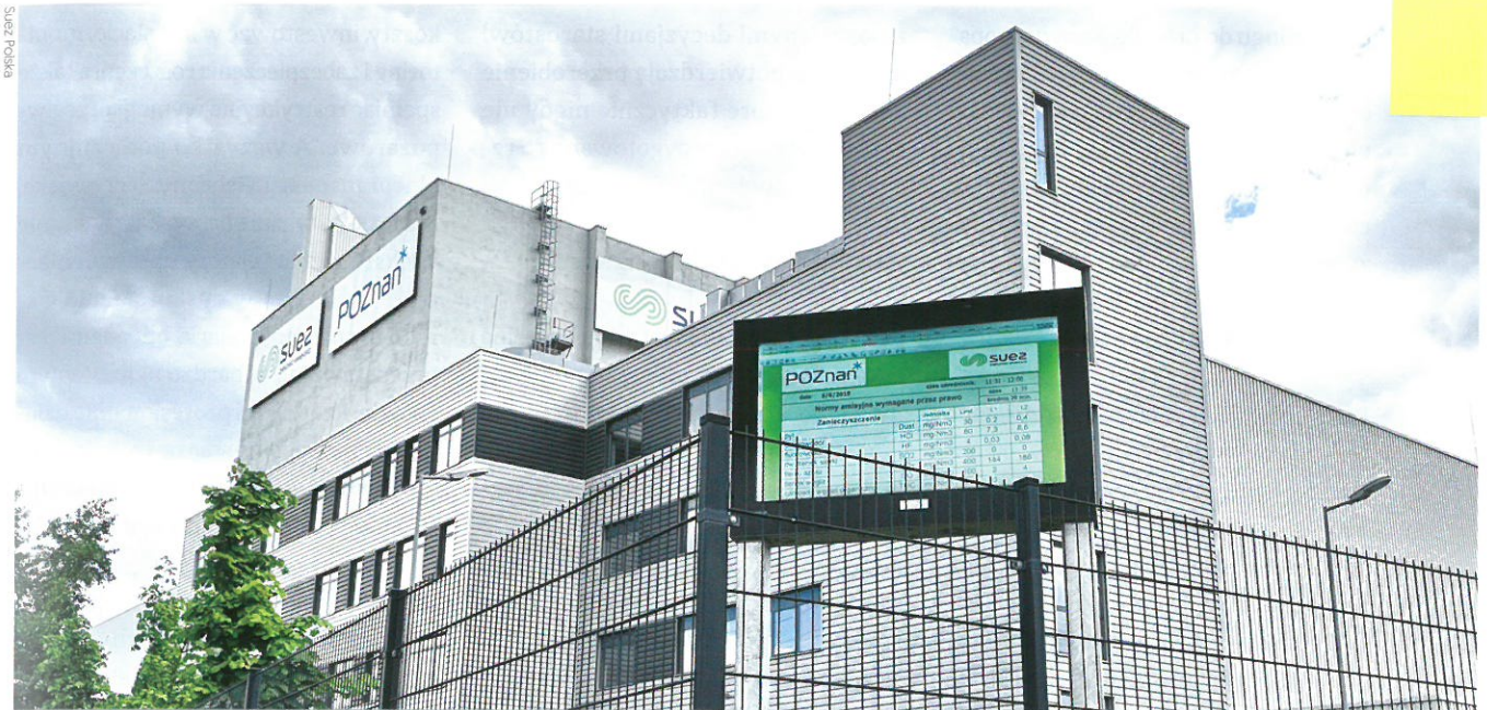
W Polsce jest za mało odpowiednich instalacji do odzysku termicznego z odpadów kalorycznych. To jedna z głównych przyczyn polskiej szarej strefy w odpadach i licznych pożarów w miejscach ich magazynowania. ITPOK Poznań zrealizowany został w formule partnerstwa publiczno-prywatnego pomiędzy spółką SUEZ i miastem Poznań
