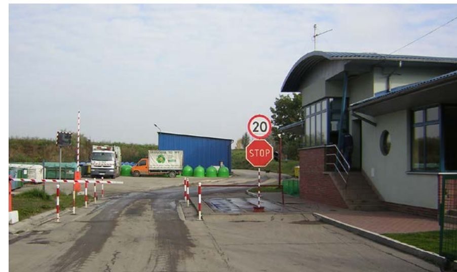
Wjazd na teren dawnego składowiska
