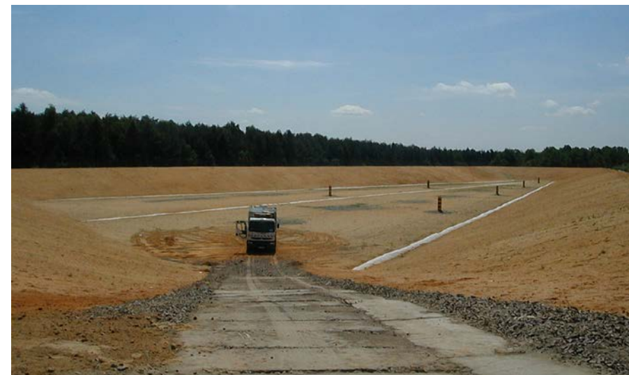
Budowa kwatery składowiska
