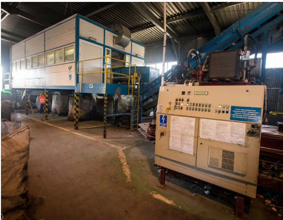
Hala segregacji odpadów
