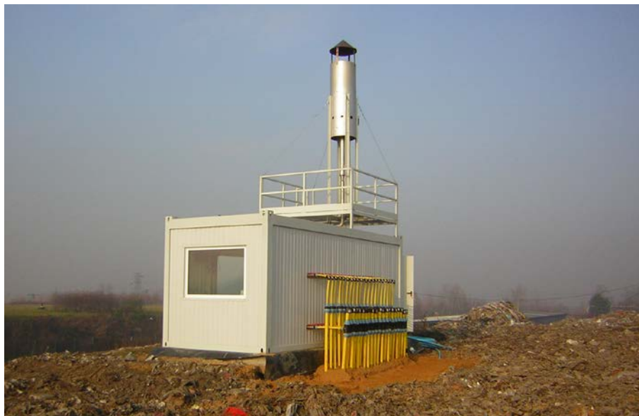
Budowa instalacji biogazu
